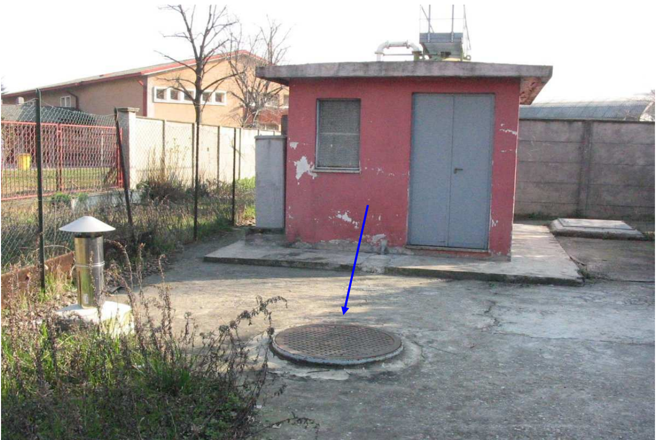
Pozzo n. 61 – vista da nord-ovest
