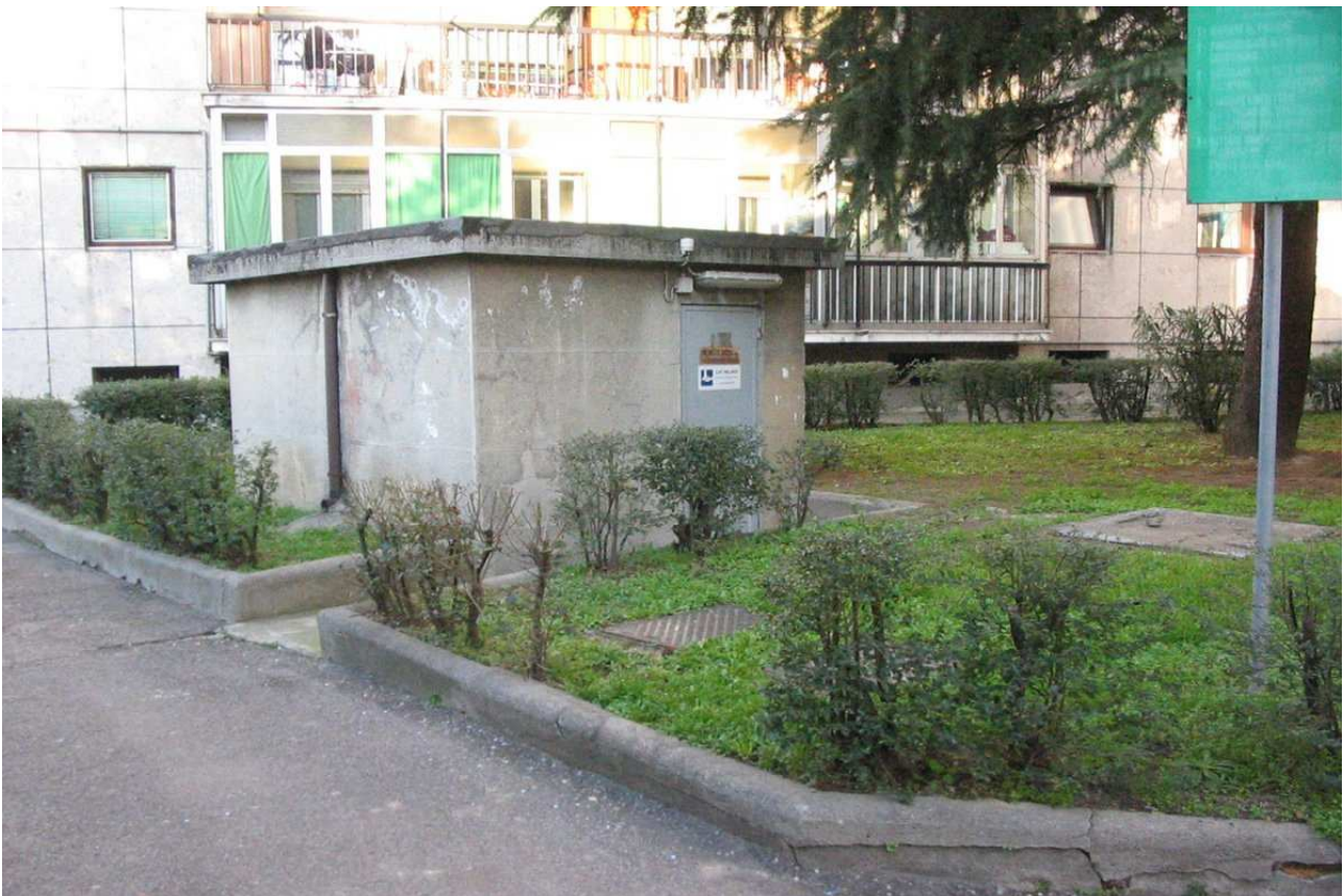
Pozzo n. 5 – vista da sud-ovest
