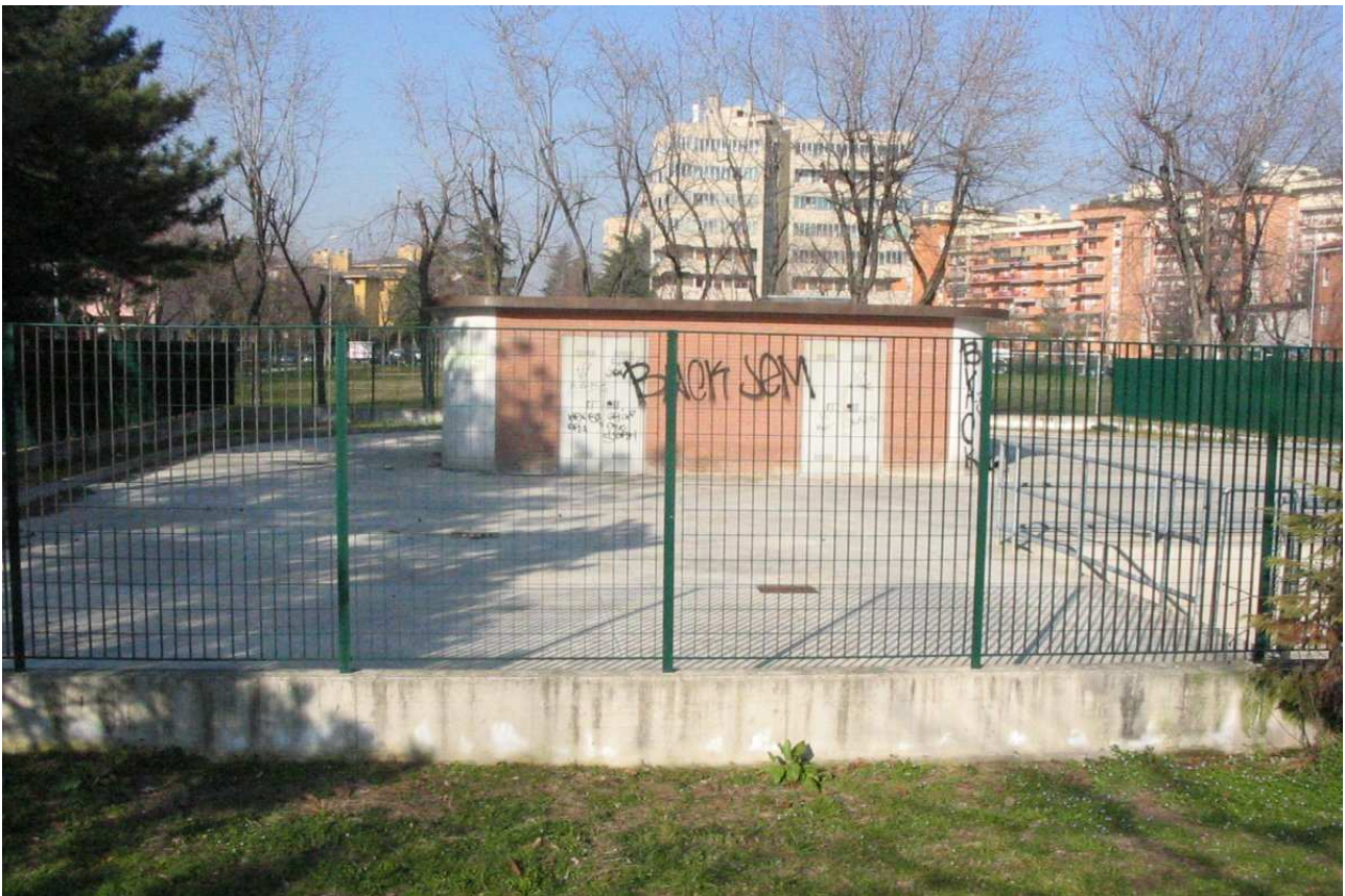
Pozzi n. 150 /151 – vista da sud
